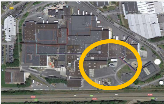
Site industriel du Groupe Bigard SA (Quimperlé)
